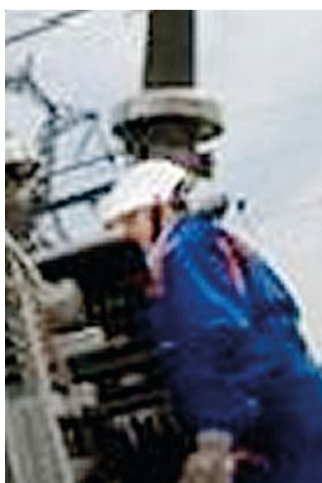
Un tecnico Enel al lavoro
