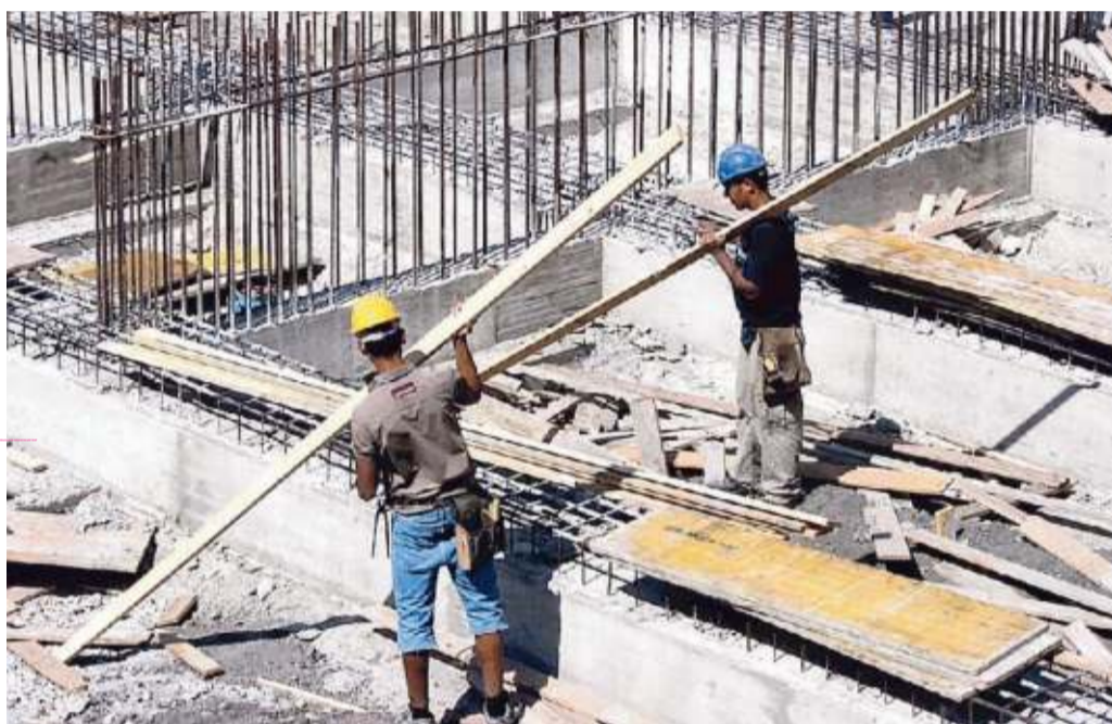
Lavoro in un cantiere edile
